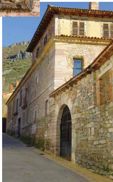
Casa de los Reyero
