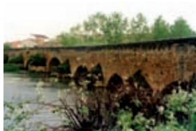
Puente sobre el río Cea
