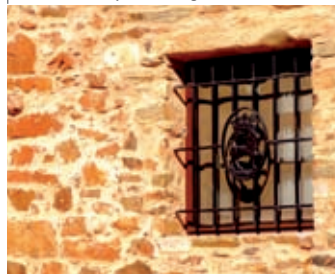
Construcción de piedra maragata
